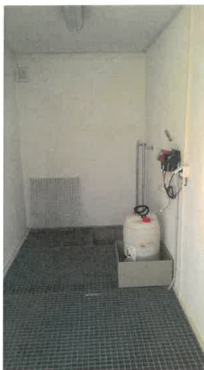
ČSV – chlorovací zařízení
