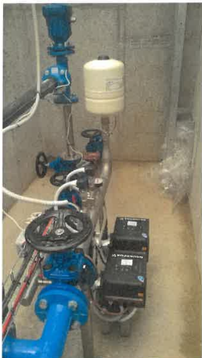
ČSV Lipolec – tlaková nádoba + čerpadla
